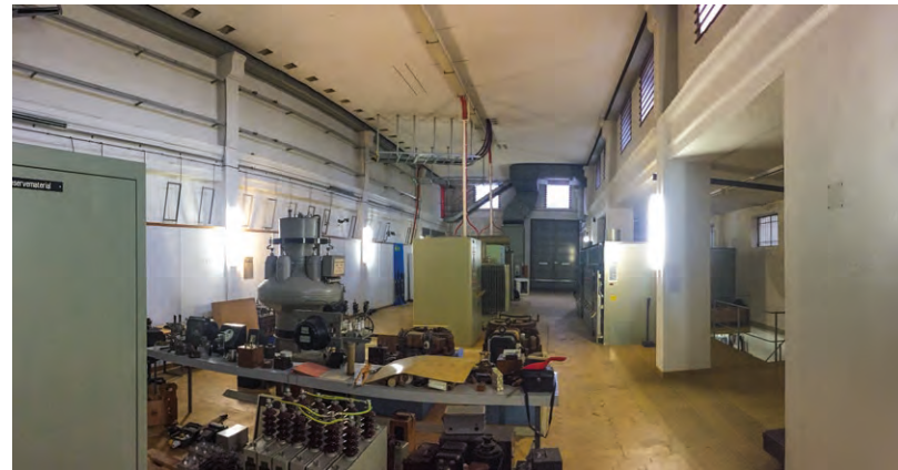
Grosszügige Räume mit Restinstallationen der ehemaligen Stromversorgung.
